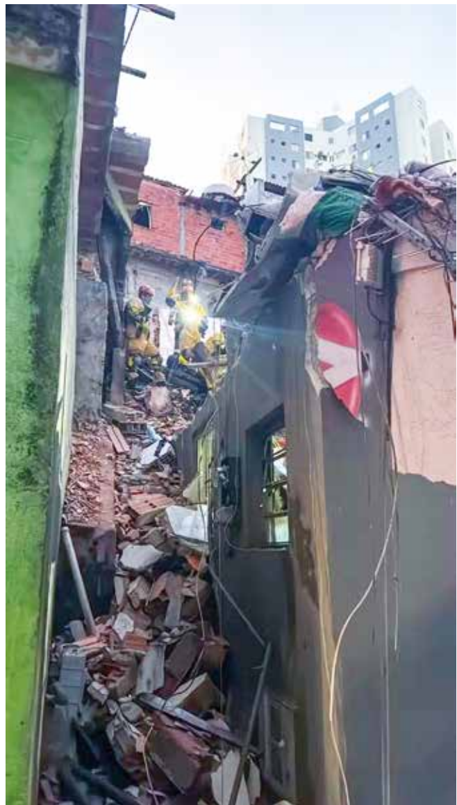
Explosão pode ter sido provocada por uma obra da Sabesp
